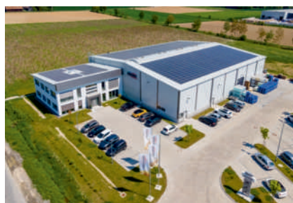
Diermeier hat nicht nur seine Logistik digital optimiert, sondern setzt auch auf erneuerbare Energien.
